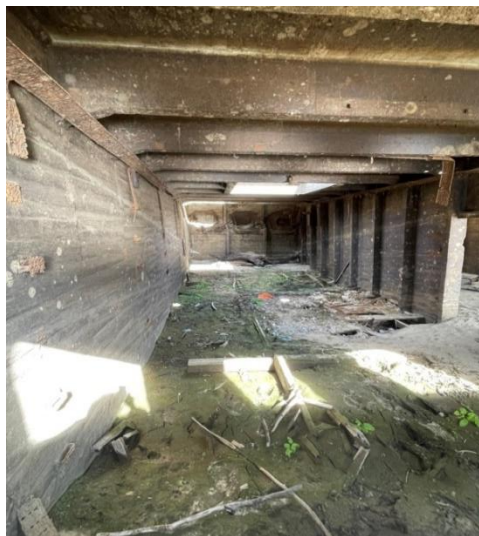
Техническое помещение. Дизельный отсек
